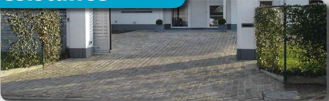
FLOWJOINT® est un mortier de jointoiment à durcissement rapide et à faible retrait avec un remarquable comportement auto-nivellant, qui est utilisée pour jointoyer les pavés, clinkers non poreux, dalles en béton et pavages où une charge et une mise en service prématurées sont souhaitées.
