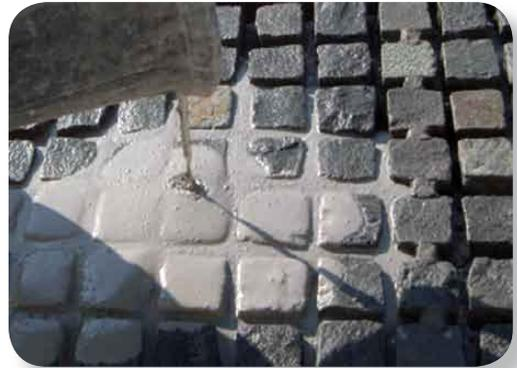
3. Appliquez le mortier diagonalement avec une raclette en caoutchouc
