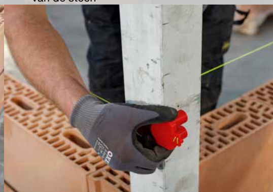
15. De metselkoord aanbrengen op \pm 2 cm onder de hoogte van de volgende laag
