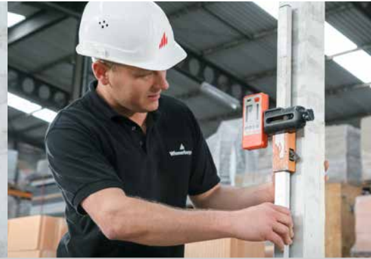
2. De vloerpas uitzetten
