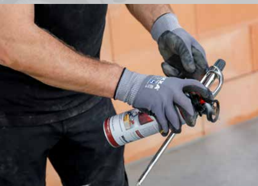
6. Bij langere pauzes de bus Dryfix extra verwijderen en de spuitmond reinigen met Dryfix cleaner
