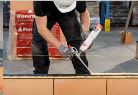
12. Twee stroken Dryfix extra aanbrengen op de waterkering
