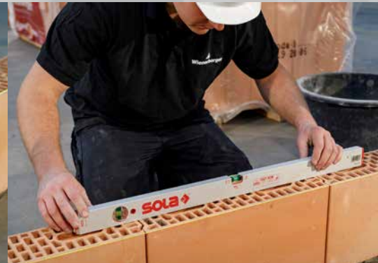
7. De vlakheid in langsrichting over 3 stenen controleren (lengte waterpas \geq 80 cm)
