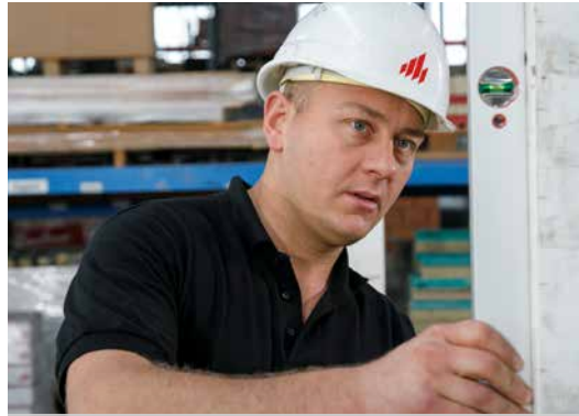
1. De profielen plaatsen
