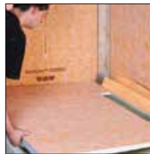
bij 3. Hellingssplaat onder de rand van de goot schuiven
