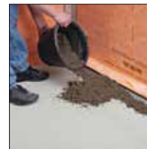
bij 3. Nivelleringslaag aanbrengen
