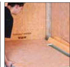
bij 3. Hellingsplaat onder de rand van de goot schuiven
