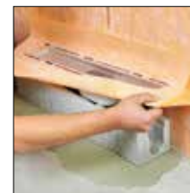
bij 2. Goot plaatsen
