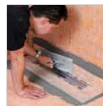
bij 4. KERDI-manchet met KERDI-COLL-L verlijmen
