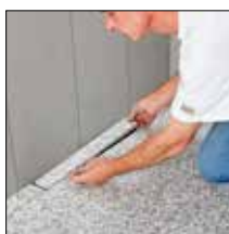
bij 6. Verlijm de bekleding – laat bij het voegen de gleuf aan de tegeldrager vrij
