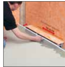
bij 4. Lijn de gootdrager uit
