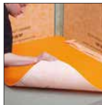
bij 8. Verlijm Schlüter®-DITRA-25 resp. DITRA-HEAT erop vast
