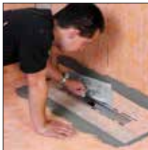
bij 4. KERDI-manchet met KERDI-COLL-L verlijmen
