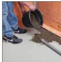
bij 6. Breng een dekvloer met afschot aan
