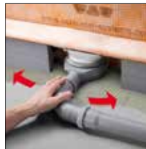
bij 5. Lijn het afvoerbuis uit
