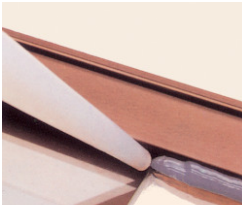
Afdichten van aluminium raamkozijn met Mapesil AC
