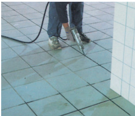
Afdichten van een keramische tegelvloer met Mapesil AC
