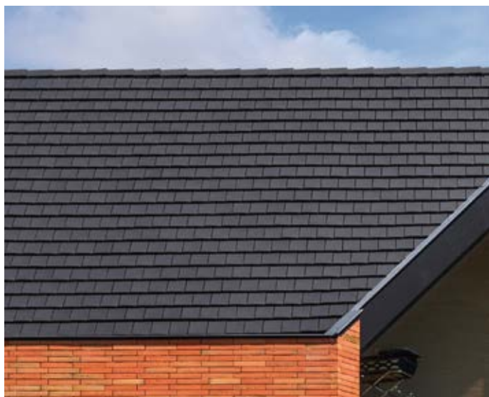
Vauban Antraciet mat - Vorst type 1900 - Gevel: Terca Linnaeus Robinia Arch. Sam Architecten - Bilzen
