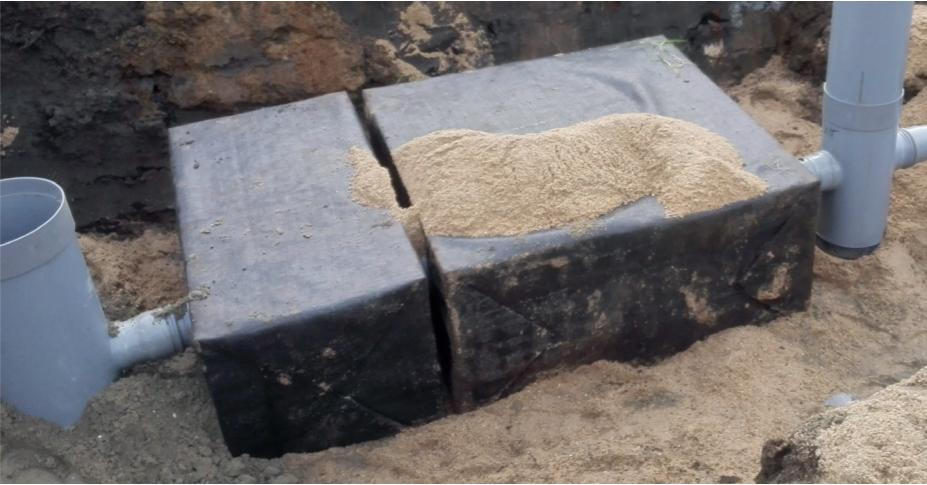
De DS Infiltratiekratten zijn voorverpakt in kant-en-klaar pakketten van 200l - 1200l. De BENOR gekeurde geo-textiel, waarin ze worden gewikkeld is een hoogwaardig, geweven doek uit kunststof; type SG29/29 (Bonar). Deze geo-textiel heeft geen risico op dichtslibben.
