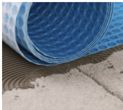
Aanbrengen van Mapeguard UM 35
