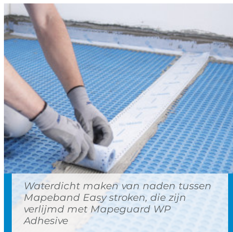
Aanbrengen van Mapeguard UM 35
