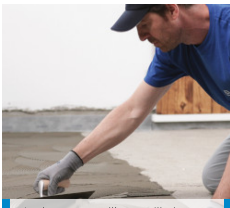
Aanbrengen van lijm met lijmkam n. 5
