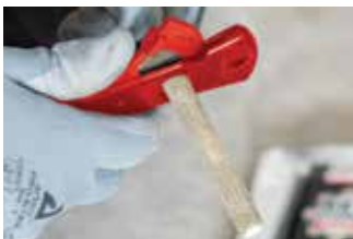
Snij de Stick op maat (= boordiepte - 0,5cm)
