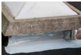
Min. 4 cm rond het vlies een laatste dikke laag aanbrengen
