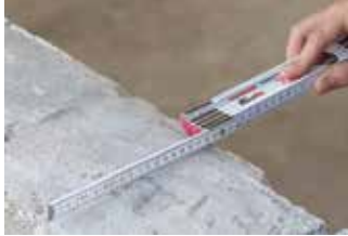
Meet de dikte van de te behandelen muur
