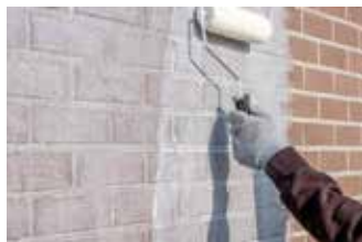
Werk in dambordpatroon (vakken van max. 1m 2 )
