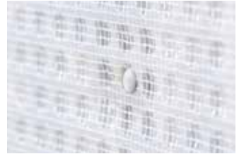
Het membraan tussen 2 pluggen steeds strak trekken
