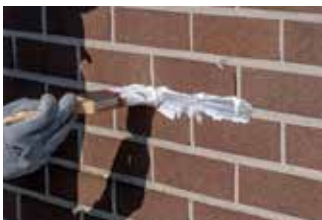
Diepere oneffenheden een extra laag geven met een borstel
