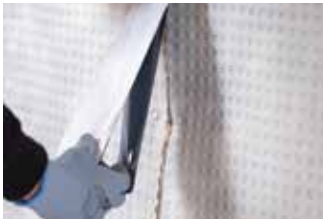
Aansluitende stroken naast elkaar plaatsen zonder overlap
