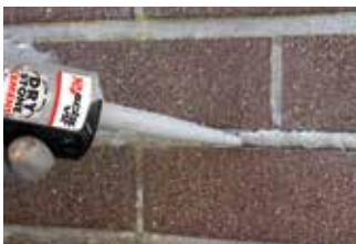
Diep in de voeg aanbrengen met een kitpistool
