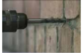
Boor elke 10-12cm gaten van 12mm door 90% van de muur
