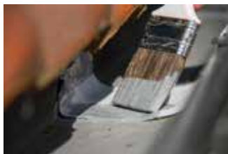
1 e laag aanbrengen en 3u laten drogen
