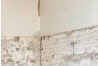
Verwijder plinten en pleisterwerk
