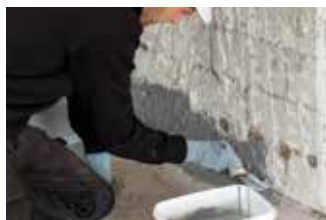
Werk tot +/- 5cm boven de boorgaten
