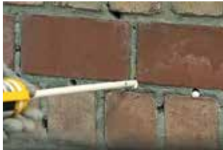
Vul de boorgaten tot 1cm voor het muuroppervlak
