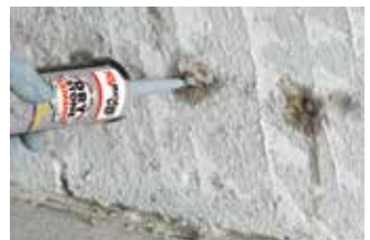
Dicht de gaten met mortel of DryStone Cement
