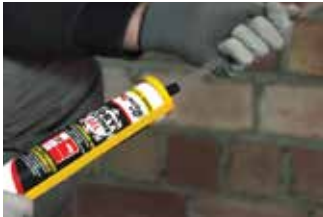
Breng de injectiebuis in tot 3cm van het einde van het boorgat
