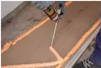
Gipskarton inlijmen met Rectavit Easy Fix
