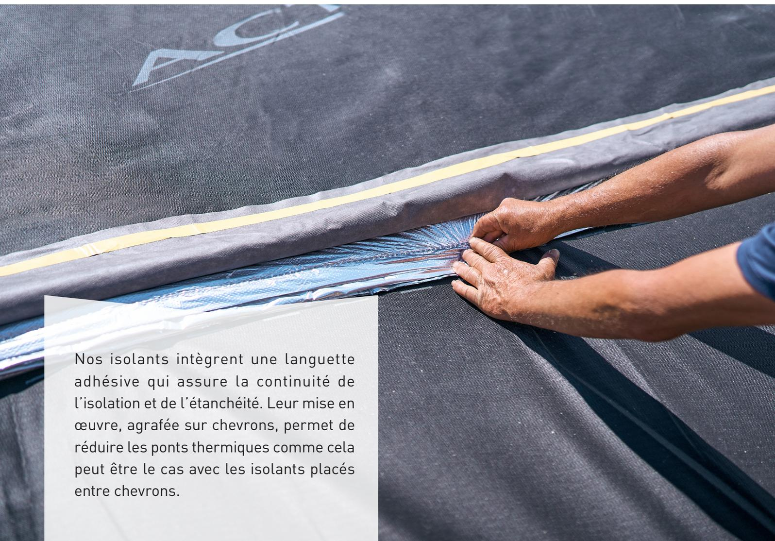
Nos isolants intègrent une languette adhésive qui assure la continuité de l'isolation et de l'étanchéité. Leur mise en œuvre, agrafée sur chevrons, permet de réduire les ponts thermiques comme cela peut être le cas avec les isolants placés entre chevrons.
