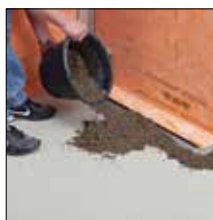
=> 5. Réaliser la chape avec forme de pente
