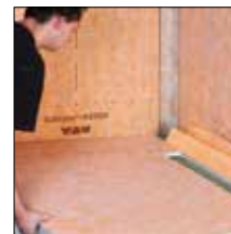
=> 3. Pousser le receveur en pente sous le bord du corps de caniveau
