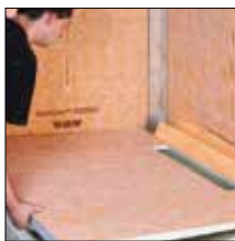
=> 3. Mettre en place le panneau avec pente de sorte qu'il arrive à fleur avec le support de caniveau
