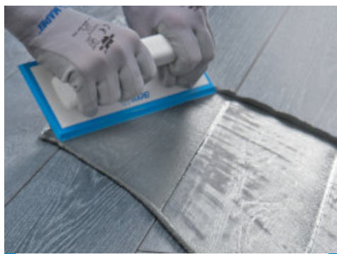
Application d' Ultracolor Plus sur un sol carrelé en grès cérame effet bois avec une spatule en caoutchouc pour joints
