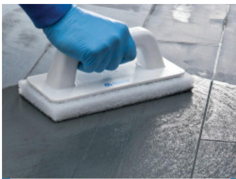
Nettoyage des joints avec un pad Scotch- Brite® (quand le produit est partiellement durci)
