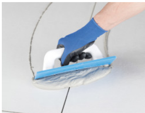
Application d' Ultracolor Plus sur un sol carrelé en grès cérame avec une spatule en caoutchouc pour joints
