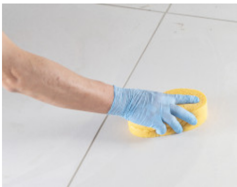
Nettoyage et finition des joints avec une éponge en cellulose dure
