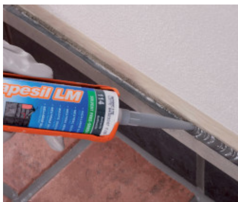
Jointoiment d'un revêtement en pierre en intérieur
