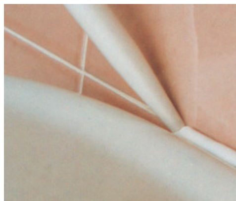
Jointoiement de sanitaires
