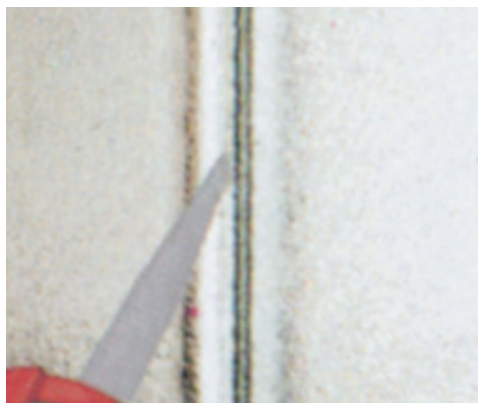
Jointoiement dans un vitrage profilé en U
