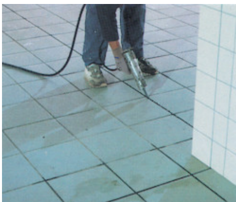
Jointoiement d'un sol carrelage avec Mapesil AC
