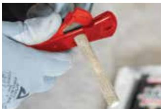
Coupez le bâtonnet sur mesure (profondeur du trou de forage - 0,5cm)
