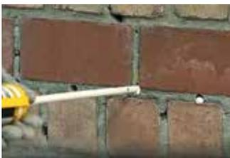
Emplissez le trou de forage jusqu'à 1 cm de la surface du mur
