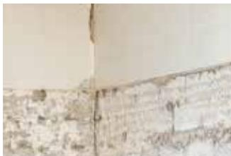
Enlevez les plinthes et le plafonnage jusqu'au-dessus de la couche de mortier à traiter
