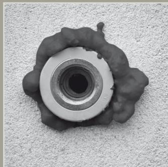
Doorsnedes of doorvoeren van elke grootte worden op betrouwbare wijze gesloten.
