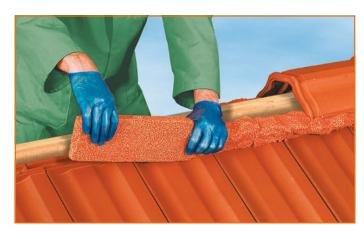
Appliquez la bande Flexim, en portant toujours les gants fournis, sur un support sec et propre. La surface d'adhésion doit être de 5 cm au minimum.
