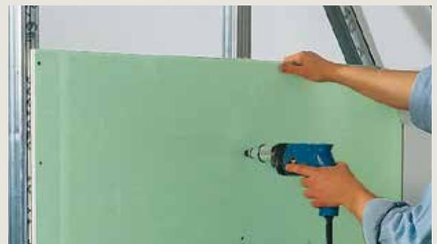
**6** À présent, visser les plaques de plâtre Knauf en quinconce à l'aide de vis rapides de 25 mm sur la première face de la cloison. Une vis tous les 25 cm. Veiller à prévoir les emplacements nécessaires pour les prises de courant et les interrupteurs et à faire passer préalablement les fils à travers les ouvertures prévues dans les profilés Knauf Magnum-Plus CW.
