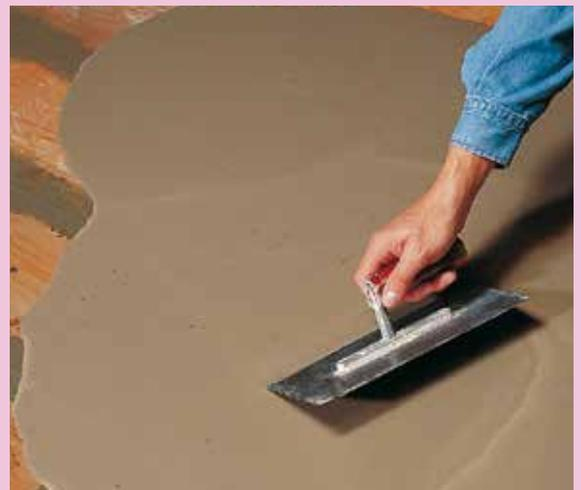
**6** Le plus simple est d'utiliser une plâtresse pour étaler correctement le produit. Si plusieurs couches s'avèrent nécessaires, appliquer la couche suivante dès que la précédente est praticable.
