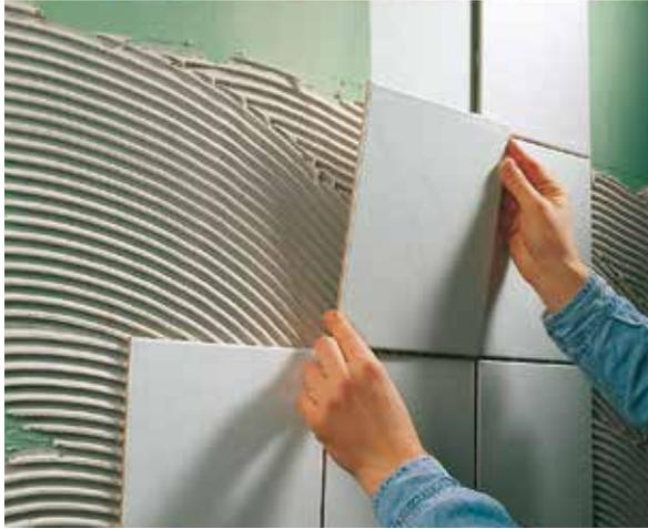
**7** Glisser les carreaux dans le lit de colle et presser. Contrôler occasionnellement le carrelage fraîchement posé en le soulevant pour vous assurer qu'il est recouvert à 80%.
