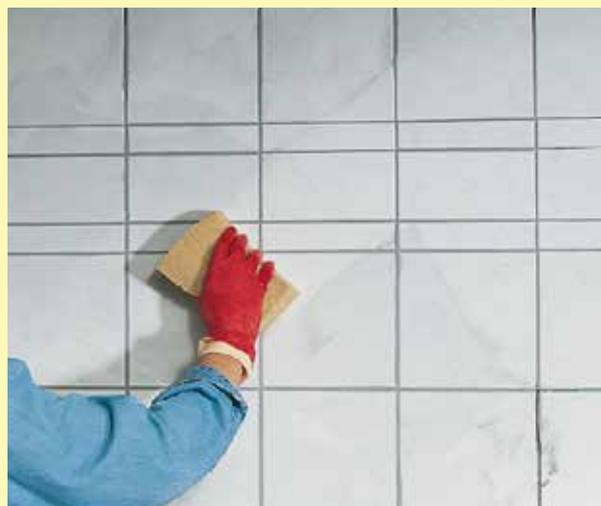
**2** Aussitôt que le mortier devient mat sur le revêtement et qu'il durcit dans les joints, commencer le nettoyage. Avec une éponge humide, lisser les joints pour obtenir un bord propre et enlever le mortier de la surface du carrelage.
