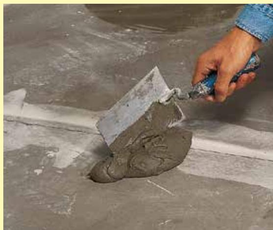
**5** Appliquer une couche régulière de colle sur le sol avec la truelle ou la palette. N'étaler que la quantité de colle nécessaire pour le temps de mise en œuvre.
