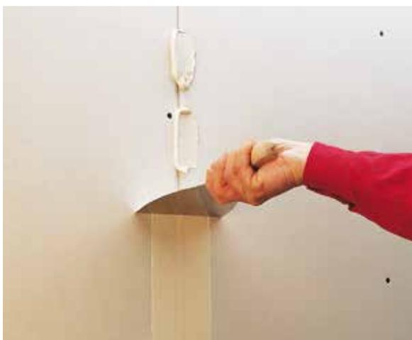
**2** Insérer Knauf Uniflott dans les joints et les trous de vis à l'aide de la spatule à manche tournevis. Retirer l'excédent d'Uniflott après env. 50 min.
