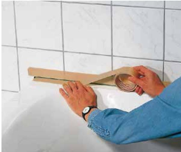
**1** Grâce aux joints à élasticité permanente, vous compensez les dilatations et les tensions de vos revêtements de sol et muraux. Afin d'éviter les souillures, coller un ruban adhésif sur les bords des joints.
