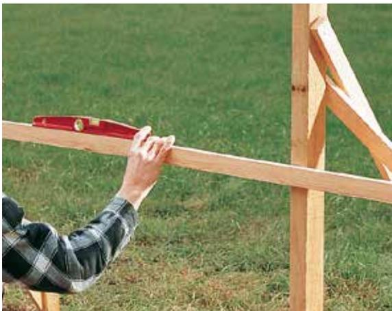
**1** Aux extrémités du mur à construire, placer des poteaux de référence. Indiquer sur les poteaux la hauteur exacte des différentes rangées de briques. Tenir compte de la hauteur moyenne des briques et de l'épaisseur du joint horizontal ( $\pm 10$  mm).
