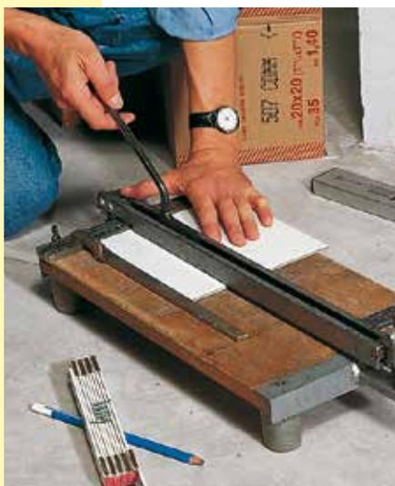
Pour obtenir des bords droits, il est préférable d'utiliser le coupe-carrelage. Il suffit de le régler à la dimension souhaitée et d'entailler la face vitrifiée.
