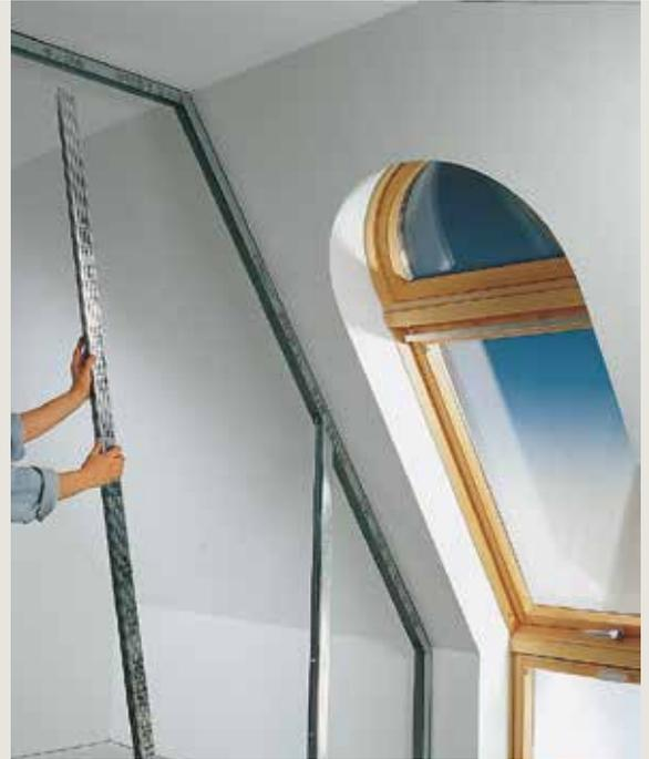
**4** Il s'agit maintenant d'insérer progressivement les autres profilés Knauf Magnum-Plus CW dans les profilés Knauf Magnum-Plus UW à une distance de 30-40 cm (selon la largeur du panneau et le type de revêtement).
