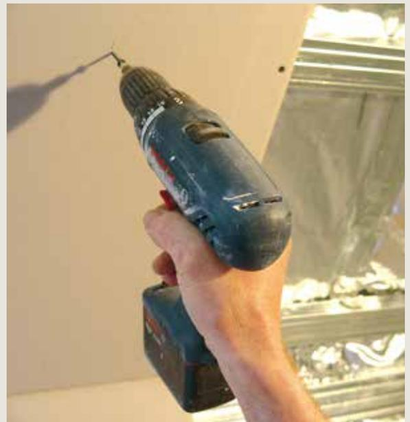
**5** Visser ensuite la plaque de plâtre Knauf au moyen de vis rapides de 25 mm sur la sous-construction. Fixations distantes de max. 17 cm. Pour éviter la formation de joints en croisillons, toujours poser les plaques en quinconce.
