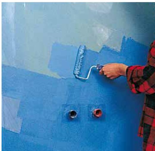
**1** Appliquer, à l'aide d'un pinceau ou d'un rouleau, l'émulsion d'étanchéité Knauf. Après séchage, recouvrir d'une couche non diluée. Si la plaque de plâtre est traitée avec le Primer universel Knauf, on peut appliquer une première couche d'Emulsion d'étanchéité Knauf non diluée.
