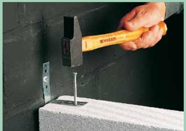
**6** Fixer la cloison toutes les trois rangées aux murs adjacents en utilisant des plaquettes spéciales en tôle prépliée. Utiliser les mêmes plaquettes au plafond et ceci tous les deux blocs. Obturer la jonction à l'aide de colle ou de la Mousse PU.
