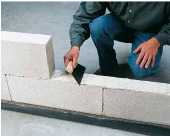
**3** Après le durcissement complet du mortier, mélanger la Colle pour blocs cellulaires Knauf pour les rangées suivantes. Avec un peigne à colle, appliquer la colle sur la face verticale et ensuite sur la face horizontale.
