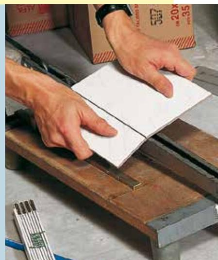
Pour des carrelages plus épais, tapoter à l'aide d'un marteau de carreleur la face arrière du carrelage après avoir effectué l'entaille, tenir le carreau de chaque côté de la ligne entaillée et le couper.
