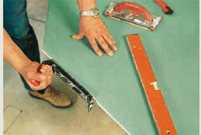
**4** Raboter soigneusement les chants afin de pouvoir, par la suite, ajuster parfaitement les plaques de plâtre.
