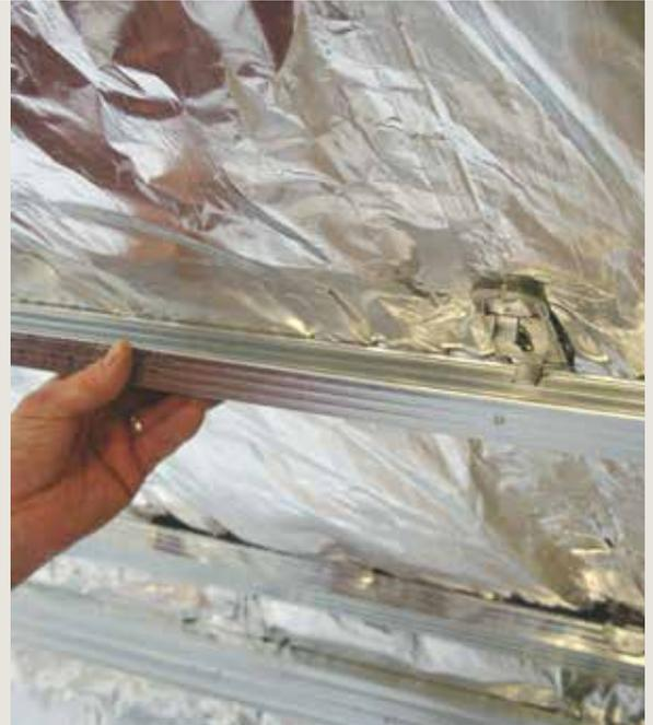
**4** Visser ensuite la suspension Knauf sur les fermes. Prévoir une fixation tous les 40 cm environ. Glisser les profilés métalliques Knauf CD 60x27 mm dans la suspension Knauf, les aligner et les fixer latéralement à la suspension à l'aide de vis Knauf Teck 9,5 mm.
