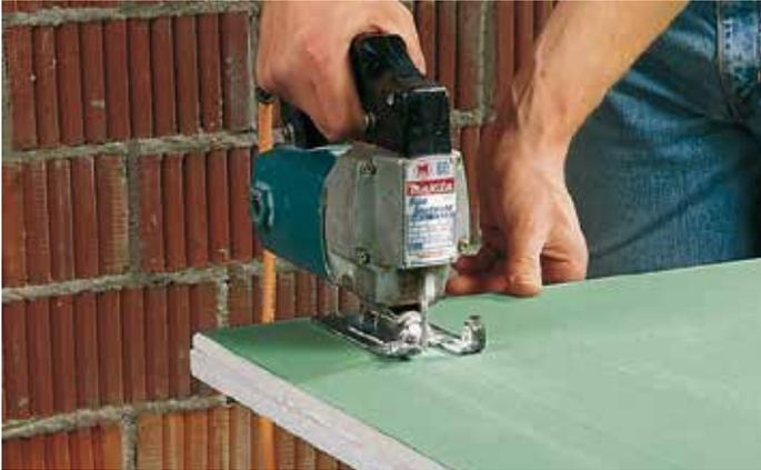
**1** Après avoir pris les mesures exactes, découper les plaques aux dimensions requises à l'aide d'une scie sauteuse ou à main. Afin de réaliser des découpes droites, nous vous conseillons d'utiliser une latte de guidage.
