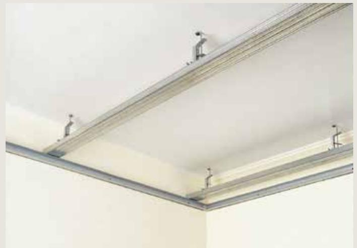
**6** Déposer le profilé Knauf de base CD 60/27 sur le profilé Knauf périphérique UD 28/27. Placer la Suspente réglable Knauf à la hauteur exacte et la clipser dans le profilé CD 60/27. Respecter un entraxe maximal de 100 cm entre les profilés de base.
