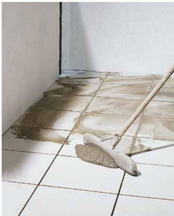
**2** Après avoir posé les carreaux sur le lit de colle, nettoyer éventuellement la surface en grattant les joints sales et inégaux à l'aide d'une cale en bois. Une fois le séchage terminé, gâcher le matériau de jointoiment Knauf, le répartir avec une raclette, en diagonale par rapport au tracé du joint, et laver ensuite avec une éponge.
