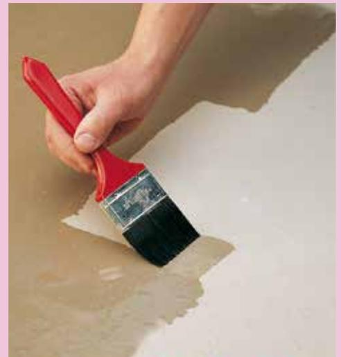
**5** Après séchage complet (temps de séchage variable selon l'épaisseur de la couche et la température environnante), traiter la couche de ragréage au Knauf Primer universel non dilué.
