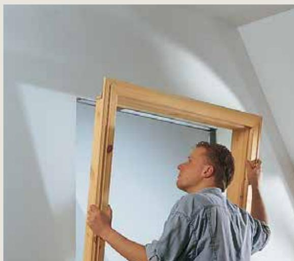
**10** Insérer ensuite l'ébrasement de la porte dans l'ouverture. Afin de lui garantir une fixation durable et stable dans la percée, le fixer avec la mousse PU.
