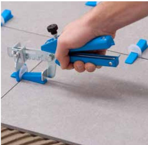
**2** Insérer la cale dans le clips. Faire attention à ne pas dépasser son point de rupture. Utiliser la pince spéciale réglable pour une insertion plus facile.
