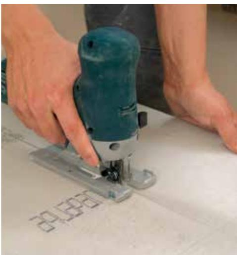
**3** Pour obtenir des surfaces de découpe parfaitement droites et sans aspérités, utiliser une scie mécanique équipée d'une lame adéquate. Les ouvertures pour les tuyaux sont à réaliser avec une scie égoïne ou une scie cloche. Le diamètre de la découpe doit être supérieur de 10 mm à celui du tuyau.
