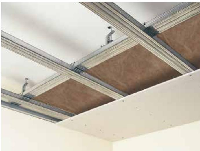
**9** La pose des plaques de plâtre se réalisera à partir d'un coin et perpendiculairement aux profilés Knauf CD 60/27. Respecter les joints en quinconce. Afin d'améliorer l'isolation acoustique et thermique, poser sur les profilés de la laine de verre de type Knauf Insulation Multifit 035.
