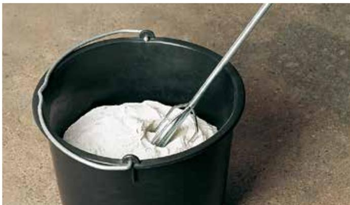
**1** Verser la quantité d'eau requise dans une cuvette propre, y ajouter la poudre et mélanger à l'aide d'un mixer mécanique, jusqu'à obtention d'une masse homogène sans grumeaux.
