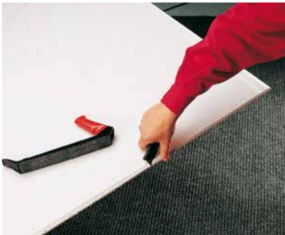
**1** A l'aide d'un couteau tranchant, façonner un chanfrein sur 2/3 de l'épaisseur des bords transversaux de la plaque. On obtient ainsi un joint en forme de V. Enlever les restes de carton en ponçant légèrement.
