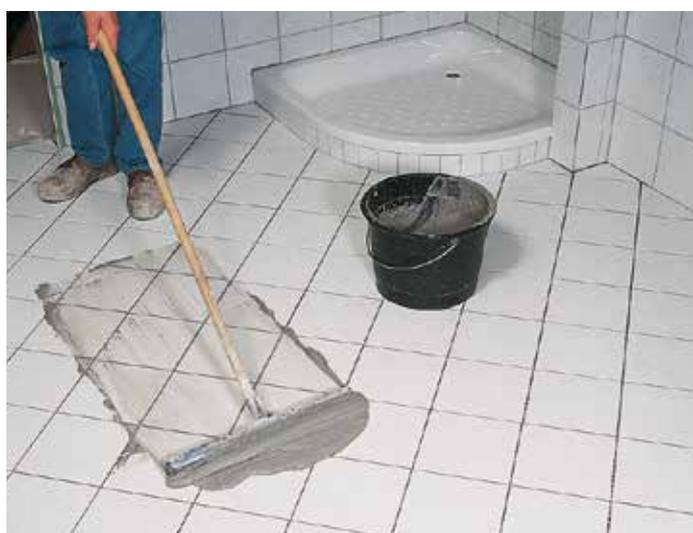
**3** Répartir le mortier avec une raclette, en diagonale par rapport au tracé des joints en passant plusieurs fois sur les joints. Une fois les joints remplis de manière égale, ôter le reste du produit avec la raclette.
