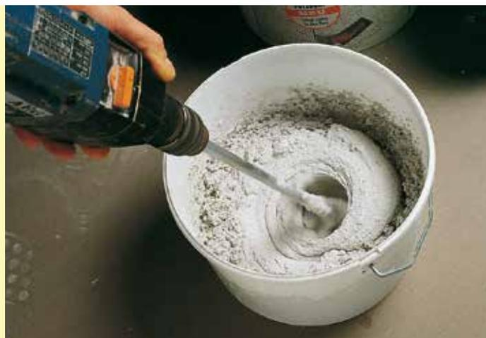
**4** Que ce soit pour les plaques en aggloméré, l'enduit de plâtre, le béton, l'enduit de ciment ou un ancien revêtement carrelé, Knauf possède la colle adéquate pour chaque support. Gâcher les colles pour carrelages en poudre Knauf avec de l'eau ou du Knauf Elast-Concentré/eau. Après un temps de pause de quelques minutes et un nouveau gâchage, les colles sont prêtes à l'emploi.
