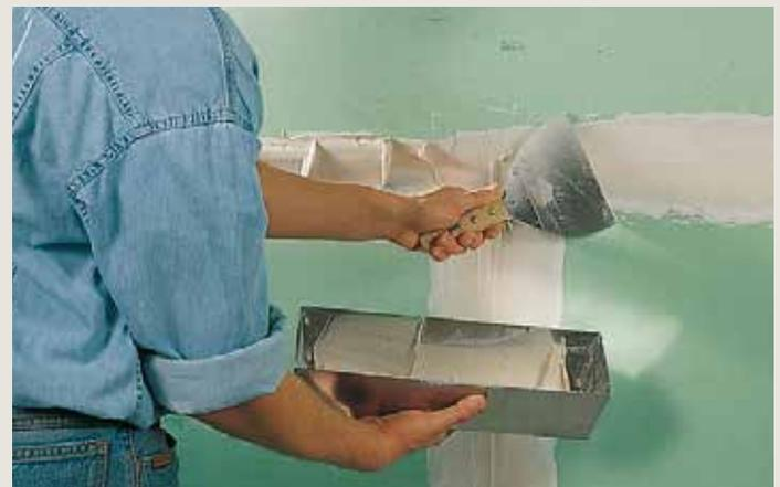
**6** Les joints des plaques et les creux, p. ex. au niveau des découpes pour fils électriques, seront obturés et jointoyés avec du Knauf Uniflott ou Jointfiller PLUS. Comme couche de finition, vous avez le choix entre la pâte prête à l'emploi Knauf F2F ou l'enduit fin Knauf Jointfinisher ou jointoyer et lisser avec Knauf Filler Pasta.
