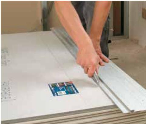
**2** Pour mettre la plaque de ciment Knauf Aquapanel à dimension, marquer le format souhaité sur le panneau à l'aide d'une règle et d'un feutre. Inciser la plaque sur une face et trancher la trame d'armature. Rompre ensuite la plaque et couper l'armature de l'autre face.
