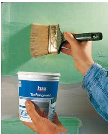
**2** En principe, il faut préparer tous les supports. Sur un support propre et sec, appliquer au pinceau ou à la brosse le Knauf Primer universel. Tenir compte d'un temps de séchage d'au moins 3 heures.
