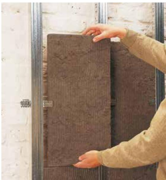
**3** Introduire les panneaux isolants en laine de verre Knauf Insulation Acoustifit entre les montants pour augmenter l'isolation acoustique et thermique de la cloison.
