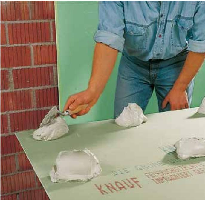
**2** Après avoir découpé les plaques de plâtre sur mesure, appliquer Knauf Perfix sur l'envers du panneau et ce, par plots tous les 30 cm. Veiller à ce que le plâtre de collage soit au moins à 5 cm du bord de la plaque.
