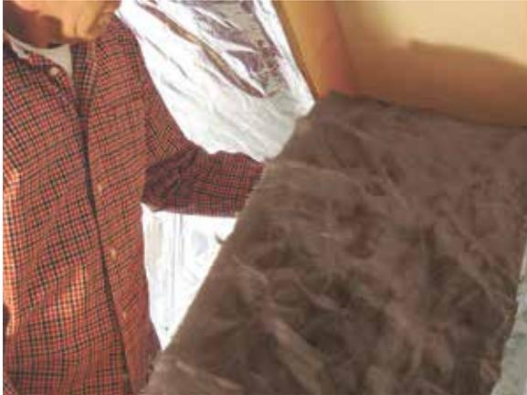
**1** L'espace habitable est devenu trop exigu. Le grenier devient l'endroit idéal pour créer de nouvelles pièces. Les fermes de la toiture sont un bon support pour y fixer un contre-lattage ou des profilés métalliques. Poser l'isolant (ici Knauf Insulation TR 312) et choisir la largeur en fonction de l'écartement des chevrons.
