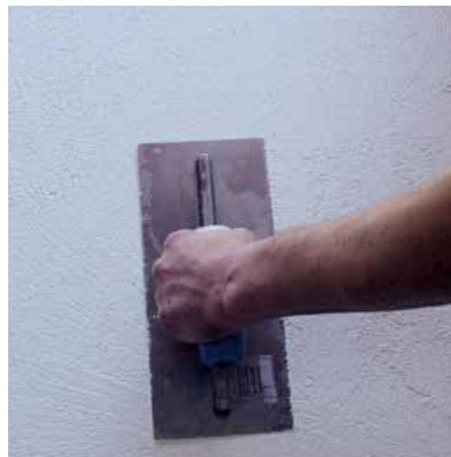
**2** Après le séchage du primer, bien mélanger le Crépi Knauf et l'appliquer (épaisseur identique à l'épaisseur du grain) à l'aide d'une plâtrasse en acier inoxydable.
