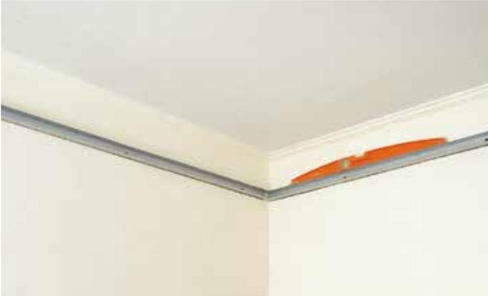
**1** Tracer sur les murs périphériques la hauteur du nouveau plafond moins l'épaisseur de la plaque. Utiliser pour cela un niveau et un cordeau-traceur. Coller sur la base du profilé Knauf UD 28/27 la bande d'étanchéité et fixer le profilé à l'aide de chevilles Knauf.
