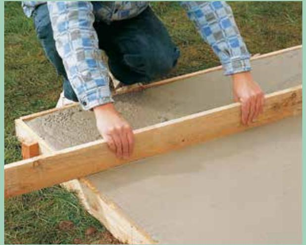
**4** Tirer le béton au moyen d'une règle. Déplacer celle-ci par des mouvements de va-et-vient.
