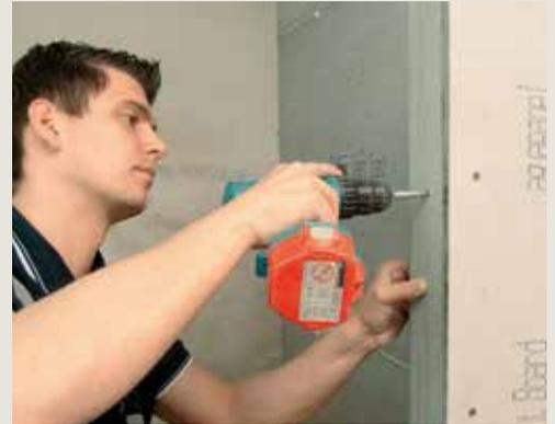
**4** Poser et visser la première plaque Knauf Aquapanel sur les profilés. Utiliser un niveau pour contrôler l'horizontalité et la verticalité de la plaque. Fixer les plaques avec les vis spéciales Knauf Aquapanel tous les 250 mm et à 15 mm des bords.
