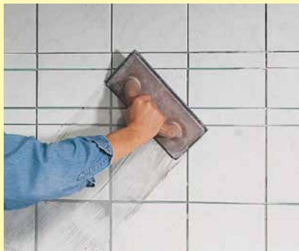
**1** Appliquer le mortier en diagonale avec une spatule en caoutchouc.
