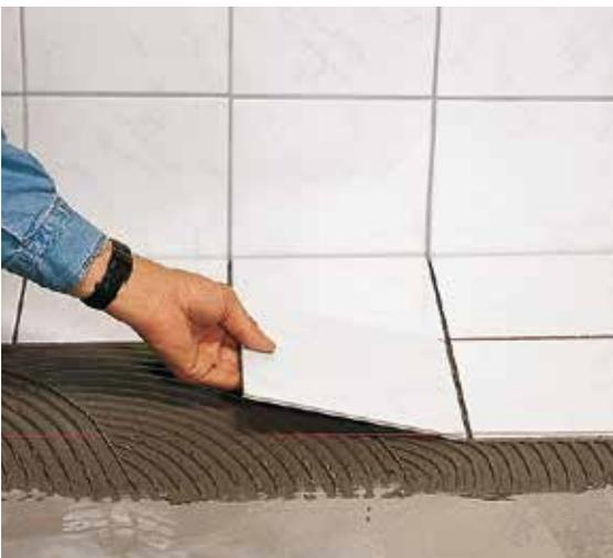
**9** Pour un alignement parfait du carrelage, poser un carreau en dessous de la première rangée chaque fois de part et d'autre. Fixer le cordeau. Disposer, à présent, la rangée de carreaux suivante le long de ce dernier. Procéder exactement de la même façon pour les autres rangées.
