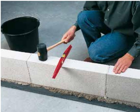
**2** La mise à niveau de la première rangée de blocs facilite l'encollage des rangées suivantes de façon considérable.
