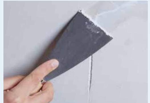
Pousser simplement la pâte de réparation et de remplissage super légère dans la cavité et lisser. Selon la couche de réparation, le Knauf Renoband peut être recouvert d'une peinture après seulement quelques heures.
