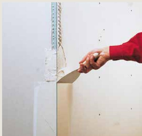
**6** Pour protéger les coins extérieurs, noyer un profilé de renfort d'angle dans le Knauf Uniflott fraîchement appliqué et lisser.
