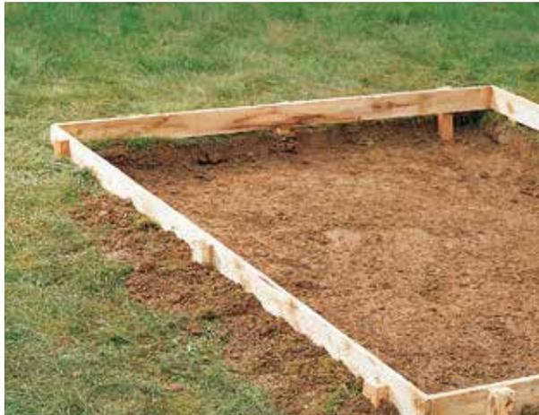
**1** Indiquer l'endroit exact de la dalle en béton. Construire sur le périmètre un coffrage à l'aide de planches en bois et de piquets tous les 50 cm. Mettre le coffrage à niveau. Tenir compte d'une certaine inclinaison afin de garantir l'écoulement des eaux de pluie.
