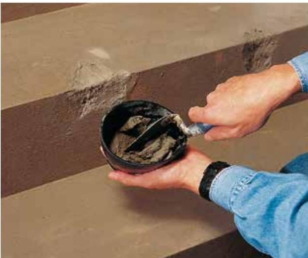
**2** Gâcher le Knauf REPA Beton dans l'eau (sans trop en mettre!) jusqu'à obtention d'un mélange sans grumeaux. Le temps de mise en œuvre du produit est d'environ 15 minutes.
