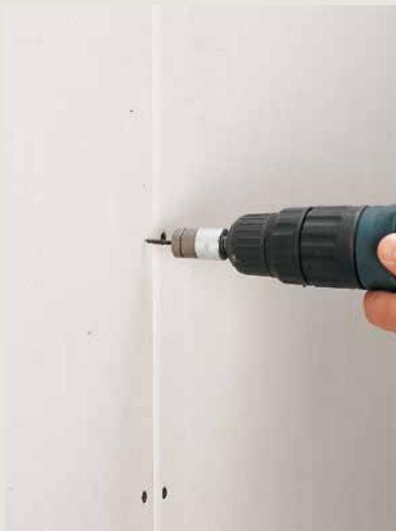
**5** Pour la fixation des plaques de plâtre, monter sur une foreuse l'embout vissage Plus Knauf. L'outillage idéal pour visser toutes les vis de la même façon.
