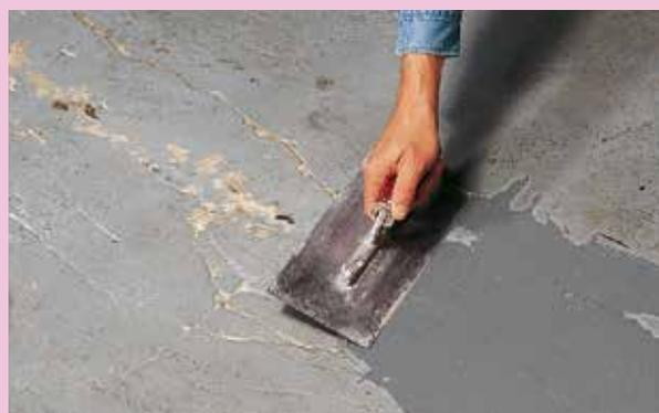
**2** Pour réparer des fissures ou des dégâts superficiels dans le support, utiliser de préférence le Knauf Ciment à prise rapide.
