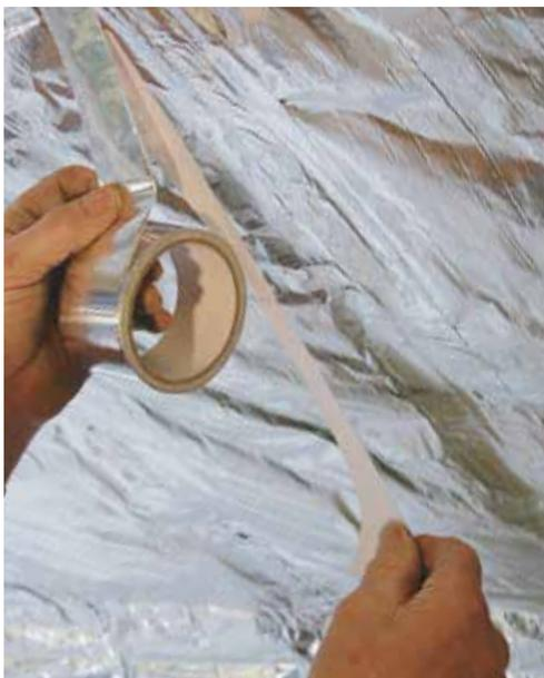
**3** Les languettes seront superposées et rendues étanches au moyen de la bande d'aluminium adhésive Knauf Thermotape Alu. Le pare-vapeur se pose toujours vers le côté chauffé de la pièce.
