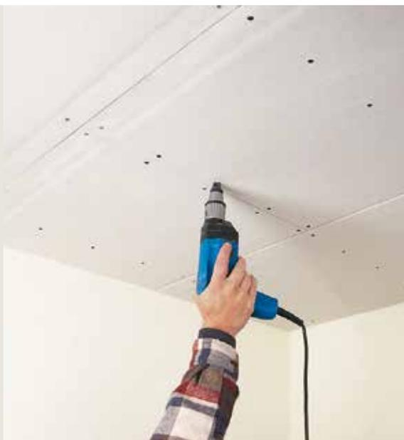
**10** A cette fin, utiliser une visseuse équipée de l'embout de vissage Knauf Plus et des vis rapides Knauf de 25 mm, à raison d'une vis tous les 17 cm.
