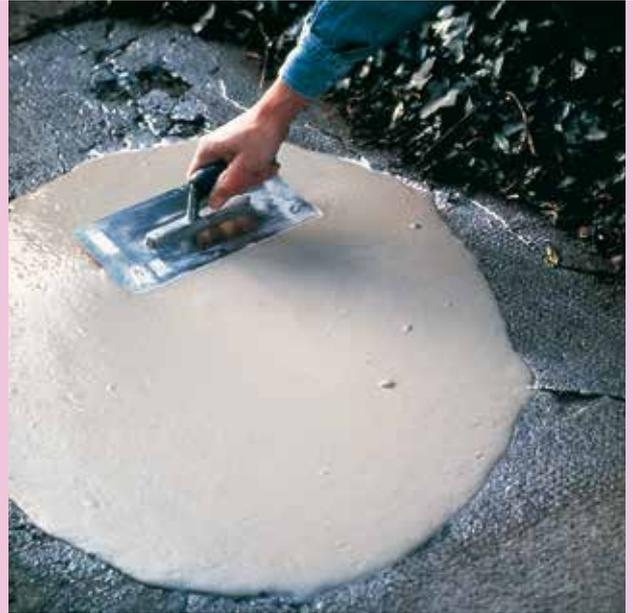
**4** Utiliser une plâtresse pour mieux étaler le matériau de ragréage. Appliquer la Masse d'égalisation Knauf en une couche de 10 à 30 mm, à l'intérieur et à l'extérieur.
