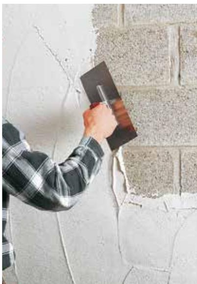
**2** Appliquer uniformément le mélange frais avec une plâtresse. Epaisseur moyenne : 10 mm et max. 20 mm. Il est possible de mettre plusieurs couches en peignant horizontalement chaque couche avec un peigne de plafonneur.
