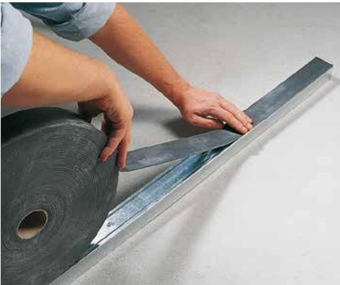
**2** Afin d'obtenir une isolation acoustique optimale, coller la bande d'étanchéité autocollante au profilé Knauf Magnum-Plus UW découpé sur mesure (pour sols et plafonds). Fixer ensuite le profilé à l'aide de chevilles au plafond et au sol (distance cheville maximum 1 m).
