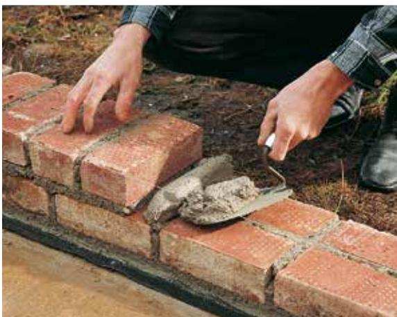
**2** Fixer le cordeau aux poteaux. Appliquer en suffisance et à la truelle le Mortier préparé Knauf et déposer la brique dans le mortier.
