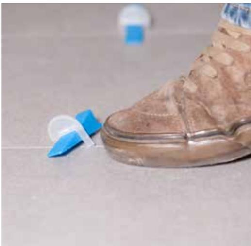
**3** Une fois la colle séchée, la partie supérieure du clip est à enlever. Pour cela, briser la partie supérieure des clips avec un maillet ou avec le pied dans le sens du joint !
