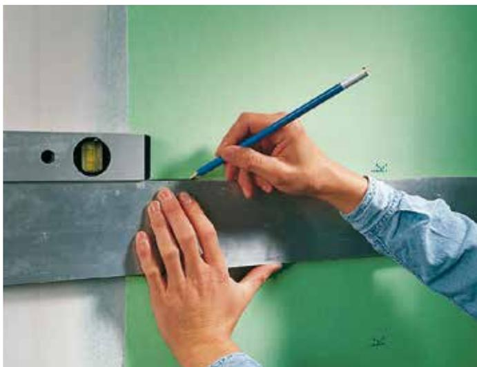
**3** A l'aide d'un crayon, d'une règle d'alignement et d'un niveau à bulle d'air, tracez une ligne sur laquelle vous ajusterez la première rangée de carrelages.
