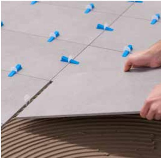
**1** Étendre la colle. Insérer le clips en-dessous des carreaux. Positionner un ou plusieurs clips à chaque côté du carreau en fonction du format de celui-ci. Positionner le carreau et l'ajuster.
