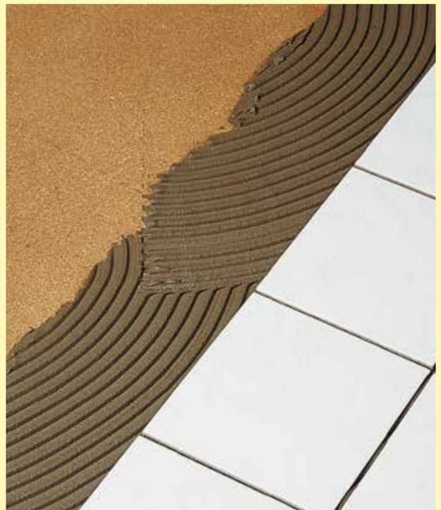
**2** Après avoir traité préalablement le support (respecter les temps de séchage), appliquer la Colle pour carrelages et matériaux divers Knauf préparée avec Knauf Elast - Concentré. Glisser les carreaux dans la colle, appuyer et tapoter avec un marteau en caoutchouc.
