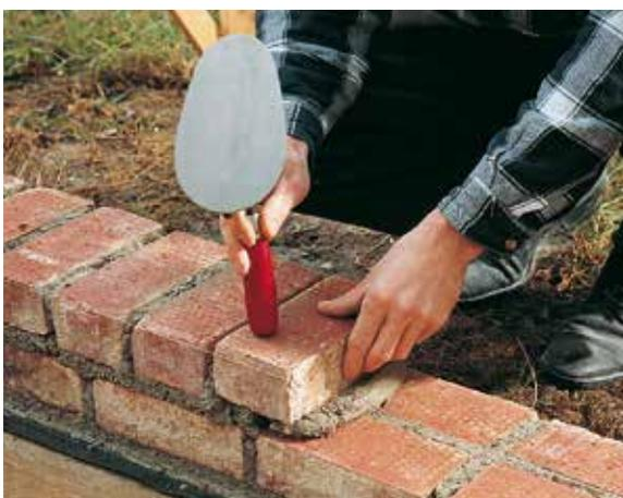
**3** Faire de même pour la brique suivante et ne pas oublier d'appliquer aussi du mortier sur la face verticale de la première brique. Serrer la brique dans le lit de mortier. L'amener à sa position définitive et parallèle au cordeau, en la frappant avec le manche de la truelle. Pour les rangées suivantes, respecter le tracé des joints.
