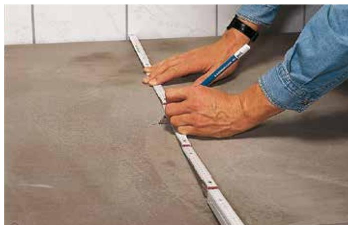
**3** Mesurer la pièce et délimiter la médiane à partir de laquelle le carrelage sera posé. Avant le collage, vérifier la répartition en disposant simplement une rangée de carreaux sur le sol.
