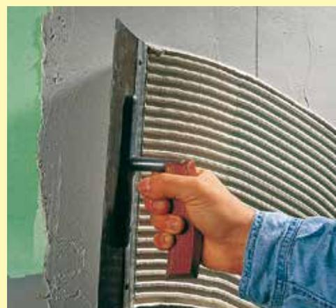
**6** Repasser sur la colle pour carrelages avec une plâtesse crantée. Si la face arrière du carreau est particulièrement profilée, employez une plâtesse crantée plus larges. Choisir la dentelure de façon à ce que la face arrière soit recouverte d'au moins 80% lors de la pose du carreau.
