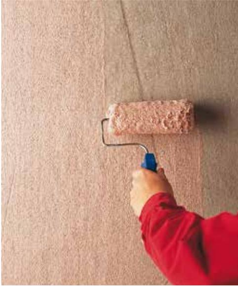
Traiter les supports très absorbants au Knauf Stuc-Primer. Diluer 1:1 à 1:3 avec de l'eau.
