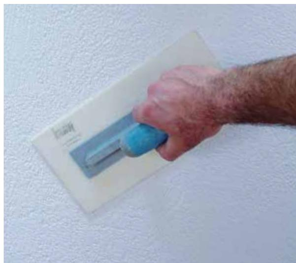
**3** Laisser durcir le crépi décoratif pendant quelques minutes avant de le structurer avec, par exemple, une taloche en PVC ou en caoutchouc.
