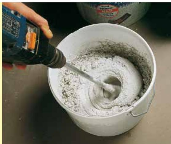
**4** Gâcher les colles Knauf - dont le choix se détermine suivant le domaine d'application - avec de l'eau ou du Knauf Elast Concentré/eau. Après un bref temps de pause, remélanger.
