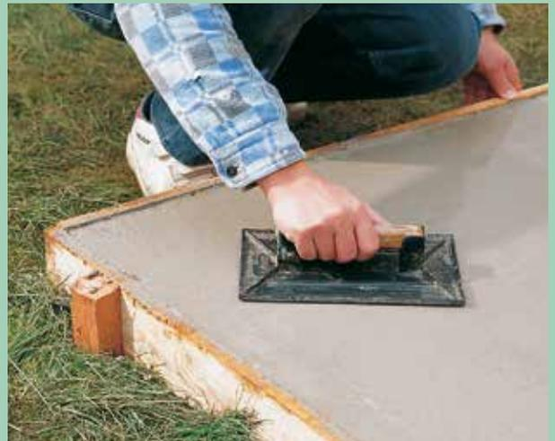
**5** Laisser durcir le béton frais. La surface peut, à votre guise, être talochée à l'aide d'une plâtresse en plastique. Ne pas lisser afin d'éviter un faïencage superficiel. Pendant une période chaude, humidifier correctement le béton et le protéger du soleil. Le gel et la pluie peuvent aussi être la cause d'un résultat imparfait.
