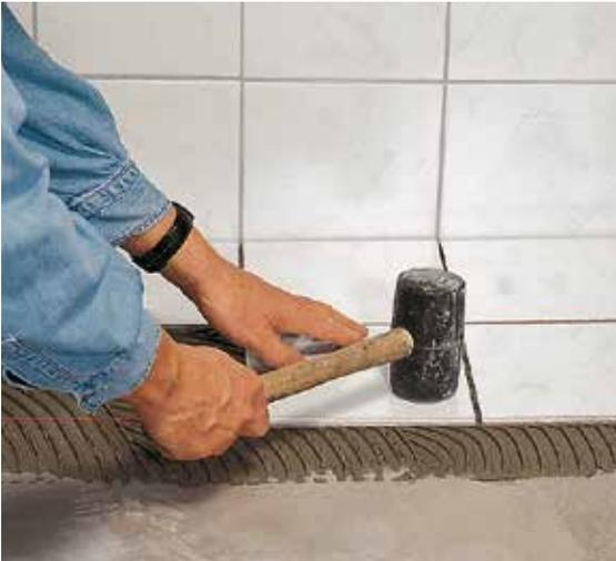
**8** Glisser les carreaux dans la colle, appuyer et tapoter avec un marteau en caoutchouc/plastique.
