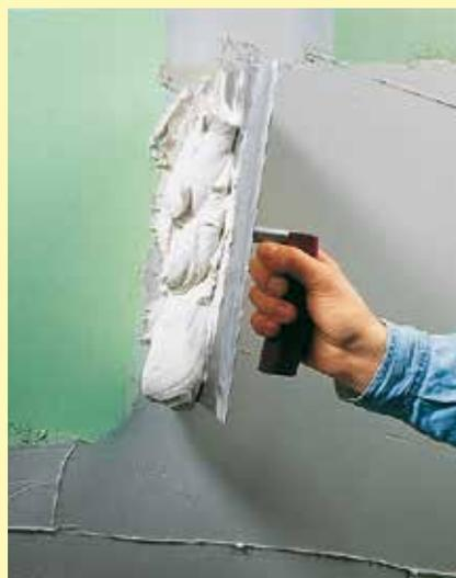
**5** Sur un support sec, étaler uniformément la colle carrelages Knauf à l'aide d'une truelle ou d'une palette, jusqu'à obtention d'une surface régulière. Attention, le temps de mise en œuvre de la colle pour carrelages est fonction de la température.
