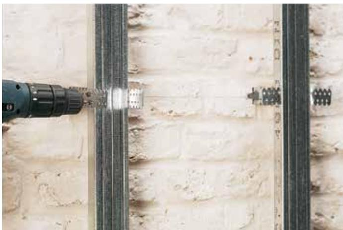
**2** Cheviller la suspension directe sur le support à mi-hauteur (max. 150 cm) du profilé vertical. Glisser le profilé Knauf CD 60x27 mm dans les profilés de base. Utiliser les vis Knauf Teck 9,5 mm pour visser le profilé à la suspension directe.
