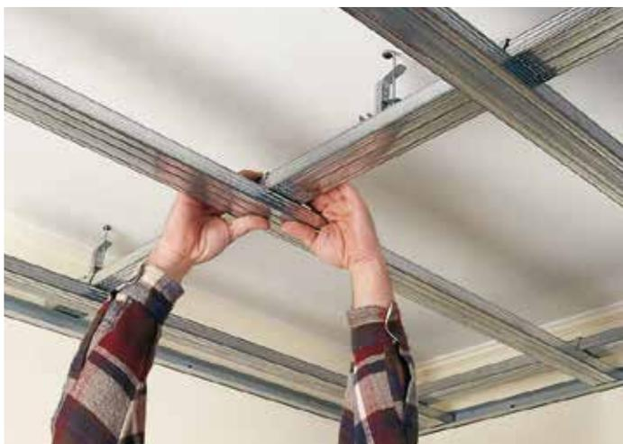
**8** Glisser, perpendiculairement au profilé de base Knauf CD 60/27, le profilé porteur CD 60/27 dans le profilé périphérique Knauf UD 28/27 et ceci, tous les 40 cm. Les premiers et derniers profilés resteront à 10 cm max. du mur. Ensuite, clipser les profilés porteurs aux profilés de base Knauf CD 60/27, à l'aide des raccords en croix Knauf préalablement montés.
