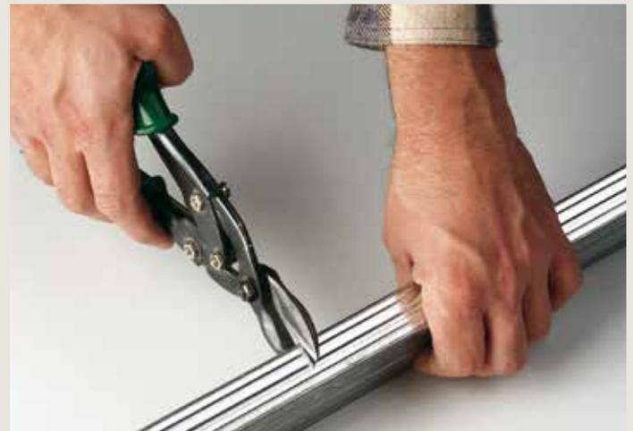
**5** Couper à longueur le profilé Knauf CD 60/27 à l'aide d'une cisaille pour métaux ou d'une disqueuse.
