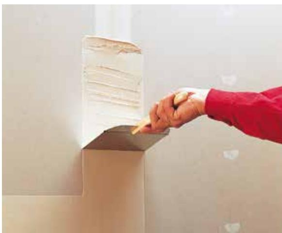
**3** Ensuite, effectuer un deuxième passage à la spatule large (20 cm). Préparer de nouveau du Knauf Uniflott. Compter environ 45 minutes entre le gâchage et le début de prise. Pour un résultat final impeccable, appliquer une fine couche de Knauf F2F pâte sur le plâtre de jointoiment séché.
