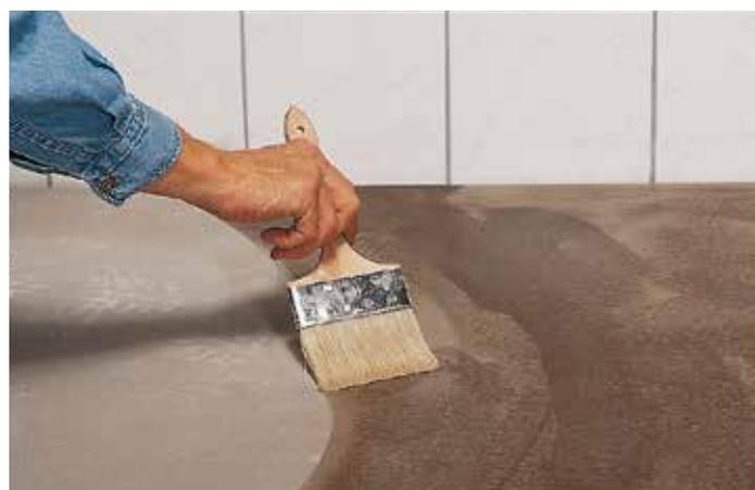
**2** Il faut préparer tous les supports. Sur un support propre et sec, appliquer Knauf Primer universel ou Knauf Emulsion d'accrochage au pinceau ou à la brosse. Tenir compte d'un temps de séchage d'au moins 3 heures.
