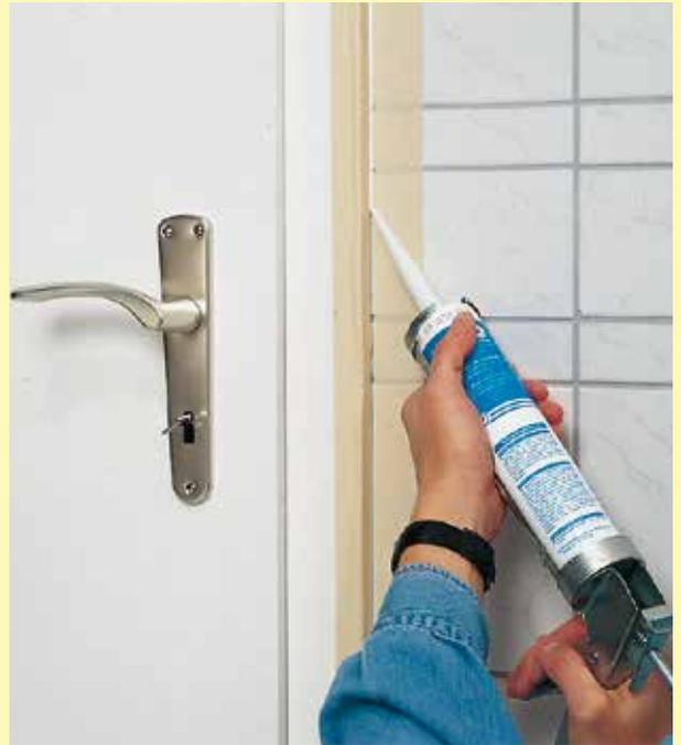
**1** Recouvrir les bords du joint (avec du ruban adhésif). Injecter ensuite une pâte silicone dans le joint entre le mur et l'encadrement de la porte. Ensuite lisser.
