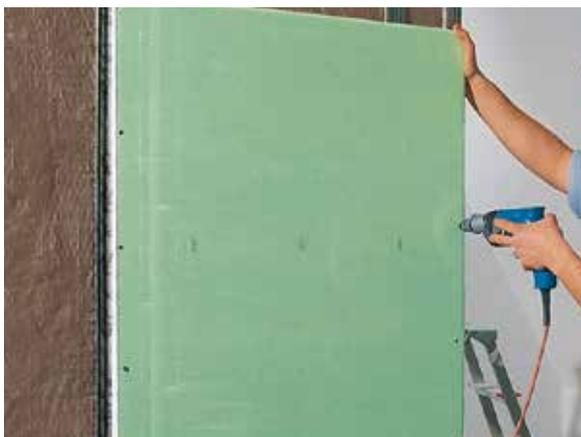
**7** Après avoir monté les panneaux isolants Knauf Insulation Acoustifit entre les montants Magnum-Plus CW, il faut également recouvrir la deuxième face de plaques de plâtre Knauf.
