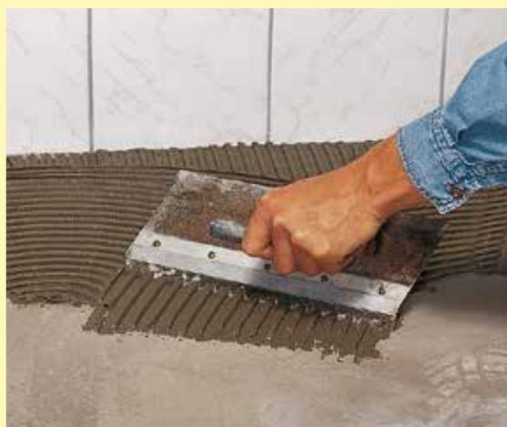
**6** Peigner ensuite la colle pour carrelages avec une plâtrasse crantée. Le choix de la dentelure est en fonction de la face arrière du carreau et du type de support.
