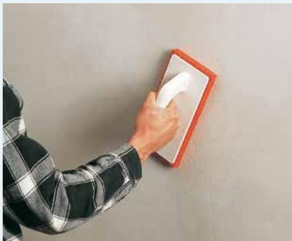
**5** Frotter l'enduit de plâtre durci en effectuant des mouvements circulaires avec la taloche en mousse pour obtenir une laitance de plâtre qui permettra le lissage ultérieur.
