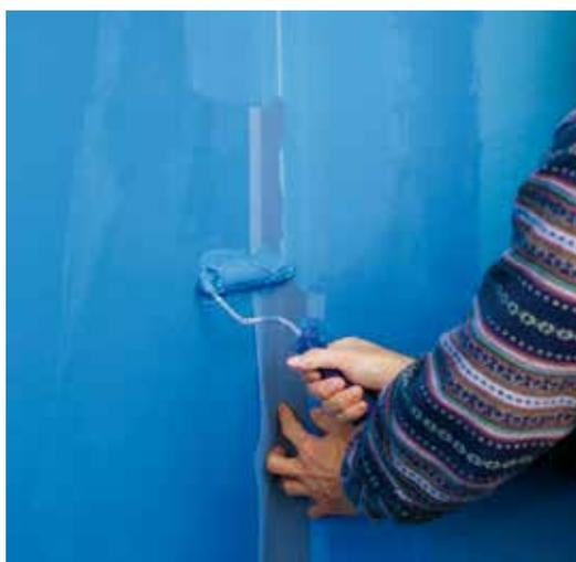
**2** Sur la couche humide, appliquer la bande et les membranes d'étanchéité. Laisser sécher et ensuite recouvrir d'une deuxième couche non diluée.
