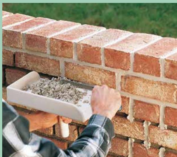
**6** Pour les joints horizontaux, tenir la taloche avec le mortier contre les joints et les remplir par un mouvement horizontal. Par après, brosser et humidifier le mur.
