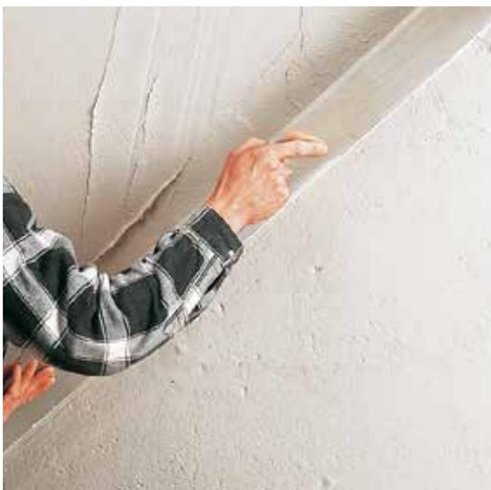
**3** Dresser l'enduit de plâtre à l'aide d'une latte en bois droite ou d'une règle métallique. Le travail doit être effectué dans le sens horizontal comme dans le sens vertical.
