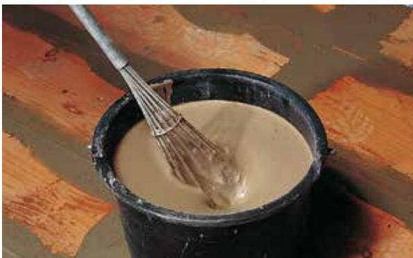
**4** Gâcher Knauf Egaline Universelle jusqu'à obtention d'un mélange sans grumeaux (le cas échéant, ajouter Knauf Elast Concentré à l'eau).
