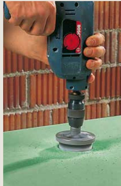
**5** Avant d'appliquer les plaques, réaliser les découpes pour prises électriques, installations sanitaires, luminaires, etc. Pour ce faire, la scie cloche montée sur une foreuse est un outil idéal.
