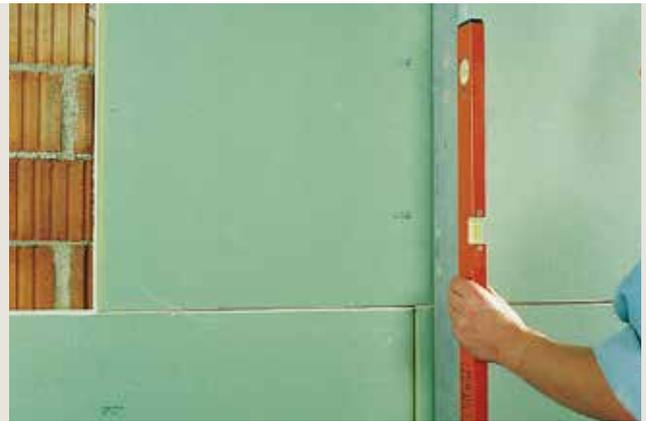
**4** Mettre les plaques d'aplomb à l'aide d'une règle-niveau ou d'un fil à plomb. Vous pouvez ajuster correctement les plaques de plâtre à l'aide d'un maillet en caoutchouc avant la prise du Knauf Perfix.
