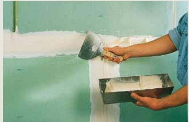
**5** Dès que le mur est entièrement recouvert, il reste à jointoyer avec du Knauf Uniflott ou Knauf Jointfiller PLUS. Pour ce faire, utiliser la spatule à manche tournevis. Comme couche de finition, vous avez le choix entre la pâte prête à l'emploi Knauf F2F ou l'enduit fin Knauf Jointfinisher ou jointoyer et lisser avec Knauf Filler Pasta. Pour renforcer les coins extérieurs, utiliser la cornière d'angle en alu ou la cornière Corner Bead Knauf.
