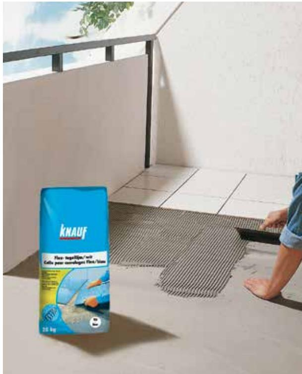
**1** Après avoir pris les mesures du support et réparti les carreaux, gâcher p. ex. la colle pour carrelages Flex Knauf avec le mixer. Veiller absolument à encoller toute la surface.
