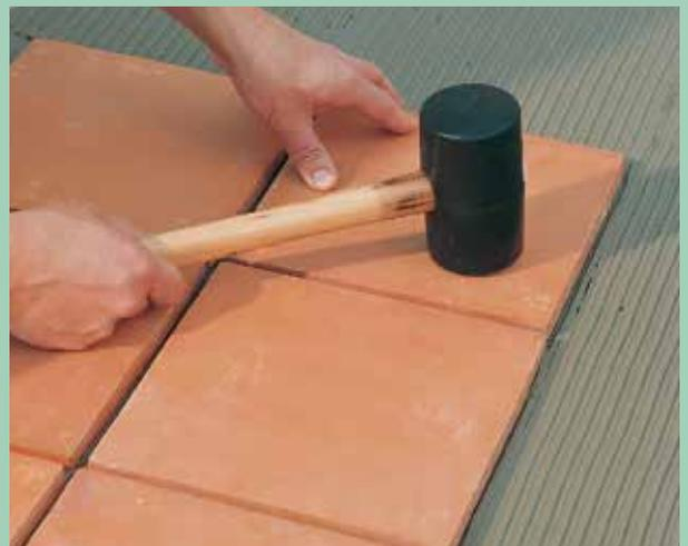
**6** Après le durcissement total du béton, enlever le coffrage en bois. Traiter préalablement la dalle en béton avec un primer. Et seulement après, carrelé.
