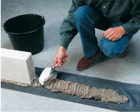
**1** Indiquer au sol et sur le mur la position de la cloison. Déposer au sol une bande de film solide et appliquer le Mortier préparé Knauf pour la première rangée de blocs. Utiliser un cordeau.
