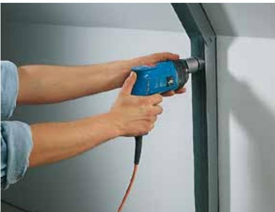
**3** Emboîter à présent le premier profilé Knauf Magnum-Plus CW (profilé vertical) dans le profilé Knauf Magnum-Plus UW et le fixer avec au moins 3 chevilles sur les murs latéraux. Ici aussi, la bande d'étanchéité est à coller préalablement.
