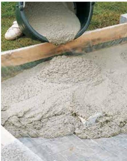
**3** Etaler Knauf Béton préparé. Préparer assez de mortier pour pouvoir couler la dalle en une fois. À l'aide du marteau, frapper sur le coffrage afin d'éviter des bulles d'air dans le béton.
