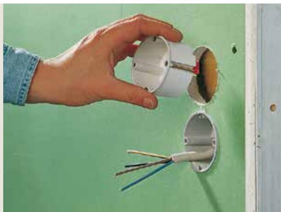
**9** Placer les interrupteurs et les prises de courant dans les emplacements prévus. Il vous est toujours possible de colmater les fissures éventuelles avec le plâtre de jointoiement Knauf Uniflott ou Jointfiller PLUS.
