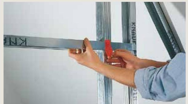
**5** Si vous voulez prévoir une porte dans la cloison, il vous suffit de faire glisser le profilé de linteau Knauf, découpé en fonction de la largeur de la porte, à la hauteur correspondante sur le profilé Knauf Magnum-Plus CW et de le fixer avec du ruban adhésif. Pour stabiliser le tout, placer et fixer un bois équerri dans le montant vertical de la porte.
