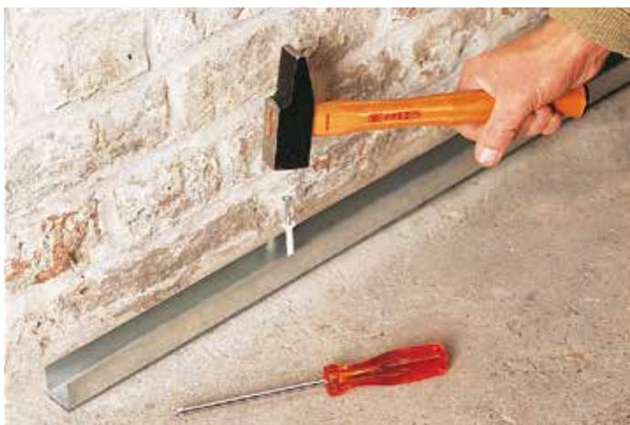
**1** Fixer au sol et au plafond le profilé Knauf UD 27x28 mm à min. 5 mm de la maçonnerie. Prévoir une fixation tous les 80 cm. Coller une bande d'étanchéité sur la base du profilé pour améliorer l'acoustique.
