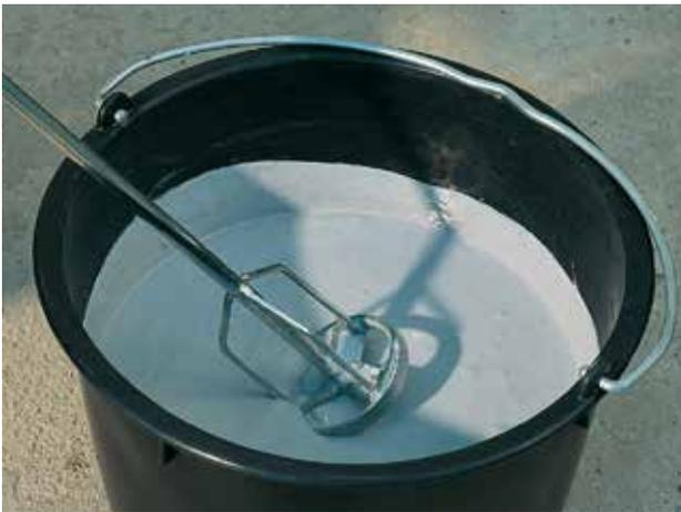
**2** Mélanger la Masse d'égalisation Knauf à l'eau (sans trop en mettre!) jusqu'à obtention d'un mélange sans grumeaux. Le temps de mise en œuvre du produit est d'environ 20 minutes.
