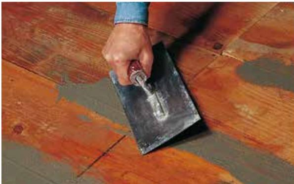
**3** Utiliser de préférence le Knauf REPA Béton pour reboucher les joints larges. Laisser sécher les réparations avant de poursuivre le travail.
