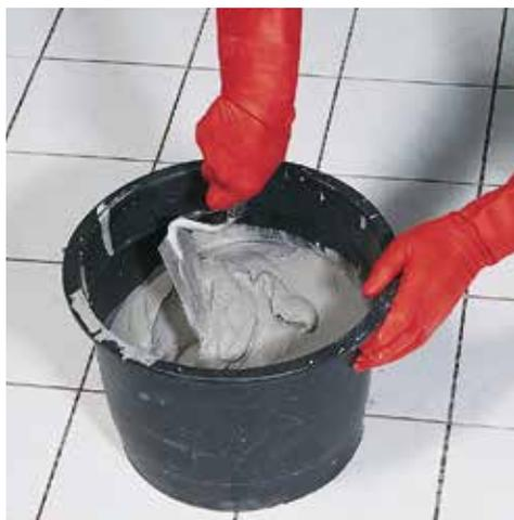
**1** Lors de l'application de la barbotine, les joints doivent être propres, exempts de poussière et avoir une profondeur égale. Il est préférable de mouiller préalablement les revêtements de carrelages particulièrement poreux. Gâcher la Barbotine Knauf avec de l'eau.
