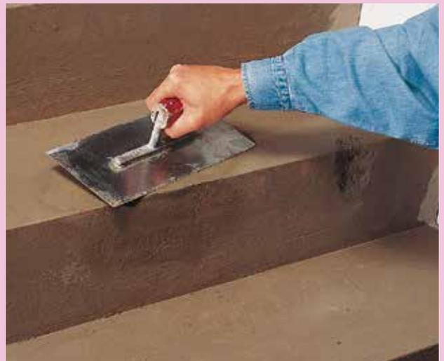
**5** Au début de la prise, lisser le produit avec une plâtresse. Knauf Réparation Universelle peut être appliquée en une couche de 3 - 40 mm à l'intérieur et à l'extérieur.
