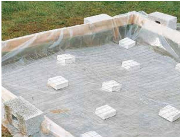
**2** Déposer un film plastique sur le sol et contre le coffrage. Prévoir des pierres, sur lesquelles reposera l'armature, à distance régulière. Le treillis métallique est à 3 cm du sol et à 3 cm min. de la surface finie ou du coffrage périphérique.
