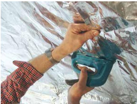
**2** Dérouler l'isolant entre les chevrons, l'ajuster et le fixer au moyen des languettes d'agrafage.
